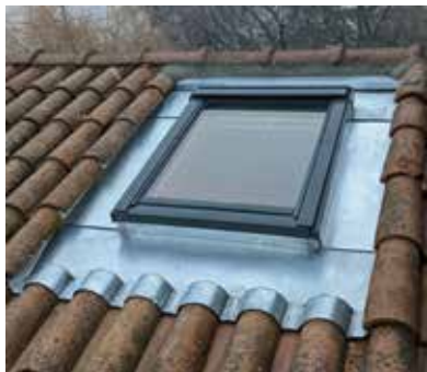
Rénovation velux avec abergement zinc.
