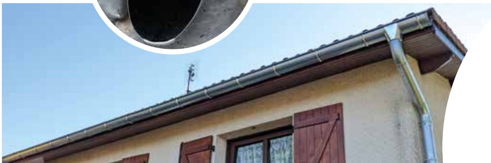
Rénovation de gouttière en zinc.
