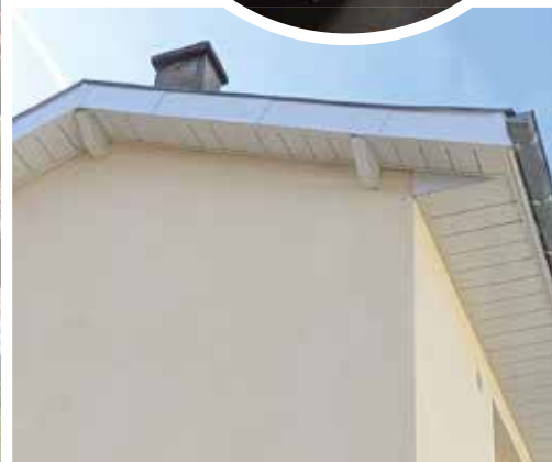
Habillage de bandeaux aluminium blanc. Sous face aluminium blanc sur mesure.
